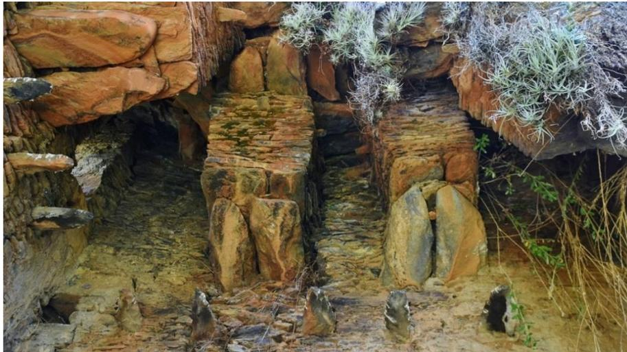
Ménsulas en la unión del muro posterior y los muros laterales.
