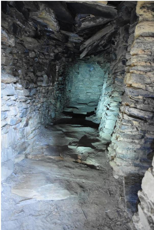
Urpish: La galería más baja dentro del muro frontal (vista horizontal). Nótese como se rompieron las piedras del dintel, y como se inclinan hacia la derecha los contrafuertes interiores y el muro de la derecha. A pesar que aparentan estar lo suficientemente sólidas desde el exterior. ¿Cuánto tiempo más faltará antes de que colapsen? El estado frágil de las construcciones es evidente.
