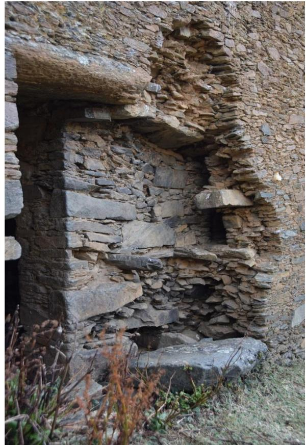
Detalle de la construcción de doble pared de una jamba de la entrada, común en torreones.
