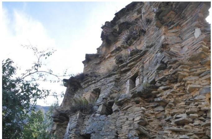
El lado interior del muro frontal, que se ha derrumbado en la parte alta.
