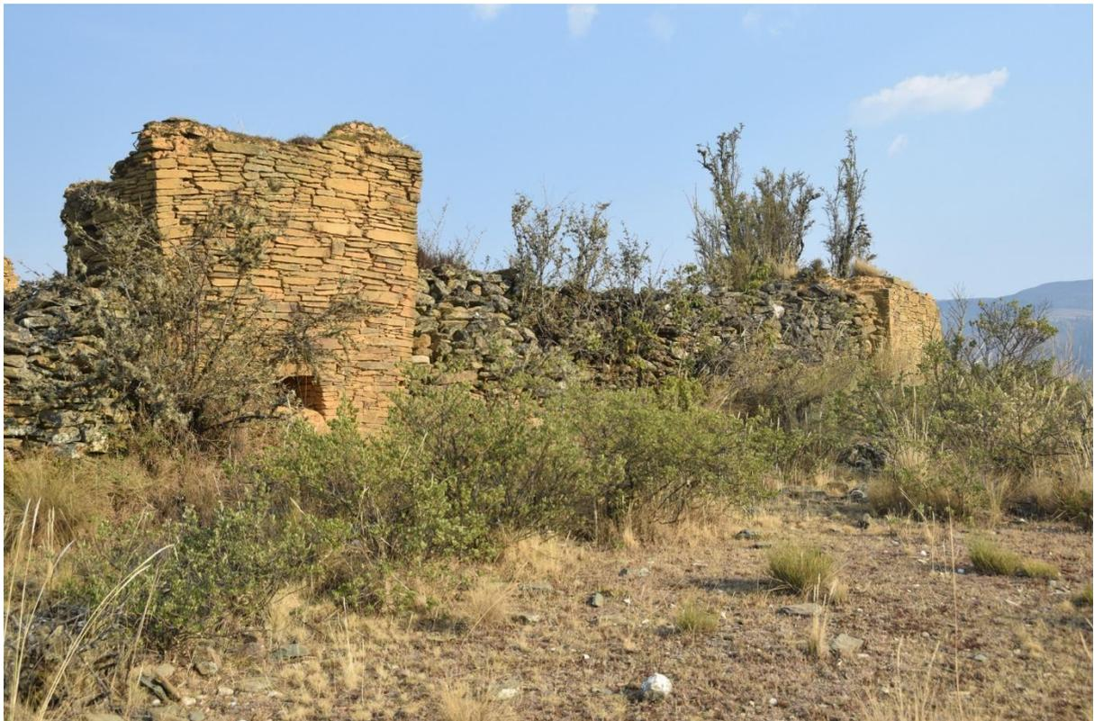
Muro perimetral exterior orientado hacia abajo. Consiste en torres cuadradas originales y un relleno posterior de piedras, presumiblemente hecho por los campesinos para restringir el acceso del ganado.
