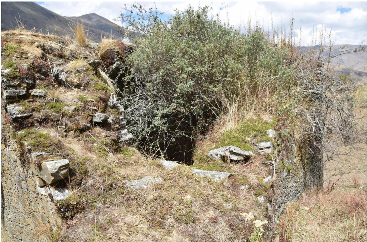
Un árbol que crece en el lado interno del muro de un torreón en Sahuay (Chupán) que ocasiona un paulatino agrietamiento de las paredes.
