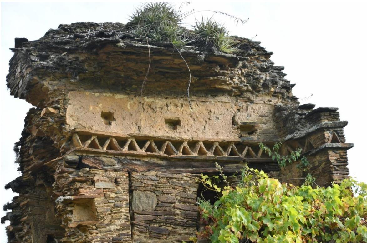
Muro exterior de la cámara superior, frente a la plataforma abierta. Nótese las cruces andinas (en forma de T) en la pared de adobe sobre la decoración en zigzag de estilo Chachapoyas y la viga de madera inmediatamente debajo de esa decoración.
