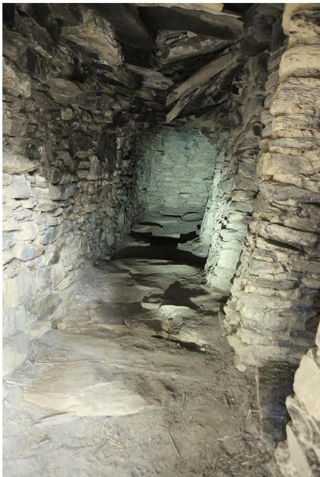
Galería dentro del muro frontal (vista horizontal). Los muros y los contrafuertes de la derecha se inclinan profusamente.
