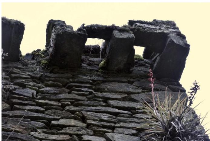
Soporte para el parapeto en la parte superior de la torre.
